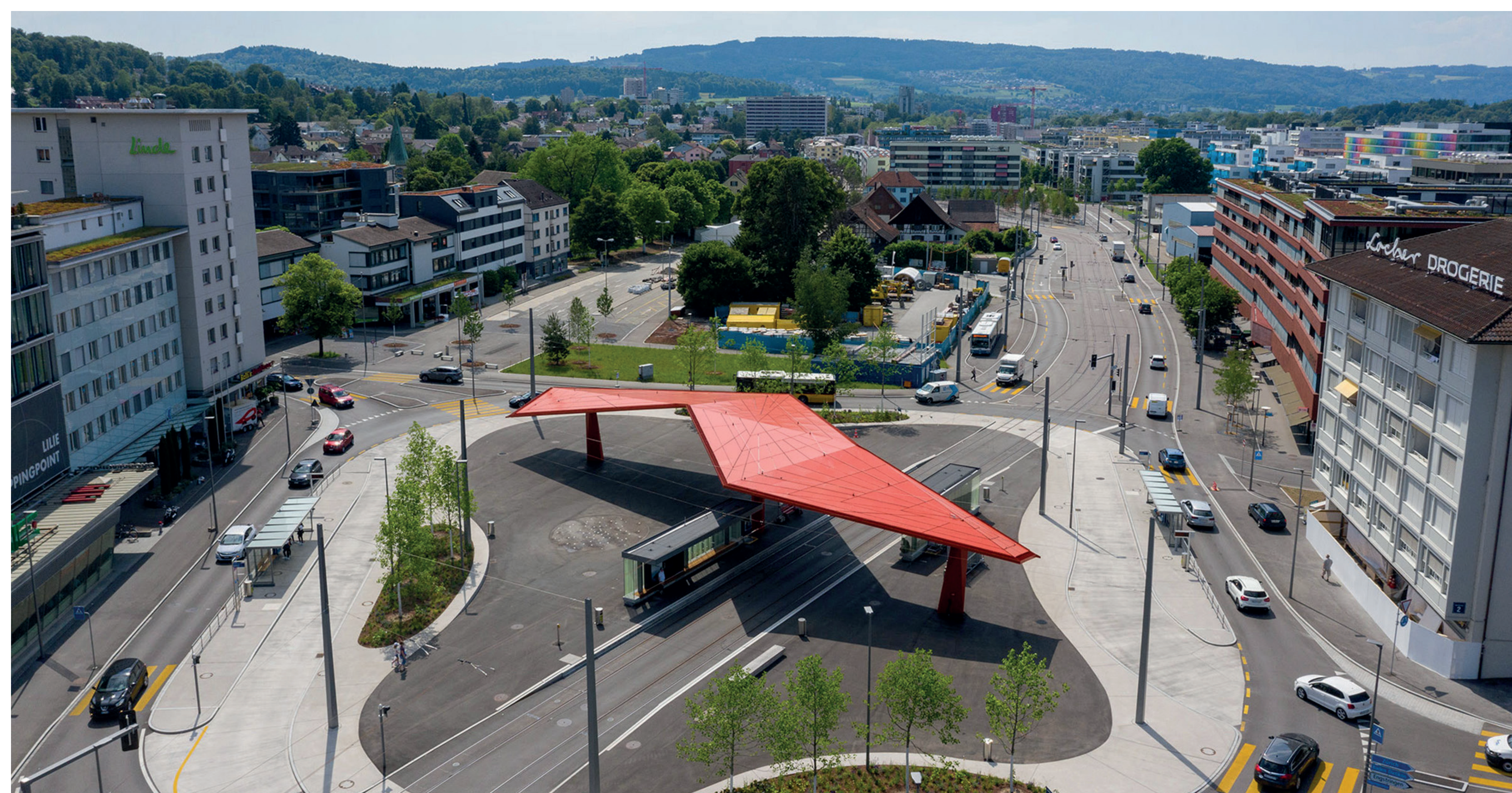
36 Limmattalbahn: Schlieren City Center (Stadtplatz, Kuhn Landscape Architects, 2019)
